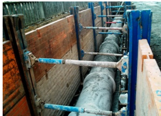
Tuberías de saneamiento y abastecimiento
